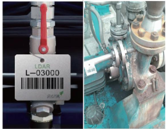
图 1 项目所用 Tag 牌示例、现场图片建档后示例
